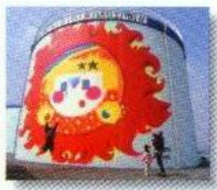
配水タンク (鯉江町)
