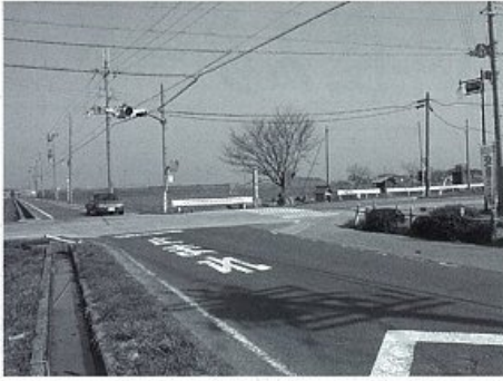
改修が待たれる上岸本五差路
