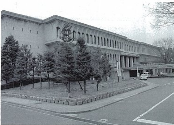
第2次耐震診断を行う予定の市役所一本庁舎
