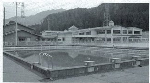
合併特例債を適用して造りかえられる山上小学校プール
