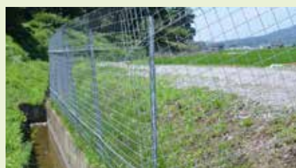
▲市内に設置された高さ約2mのフェンス
