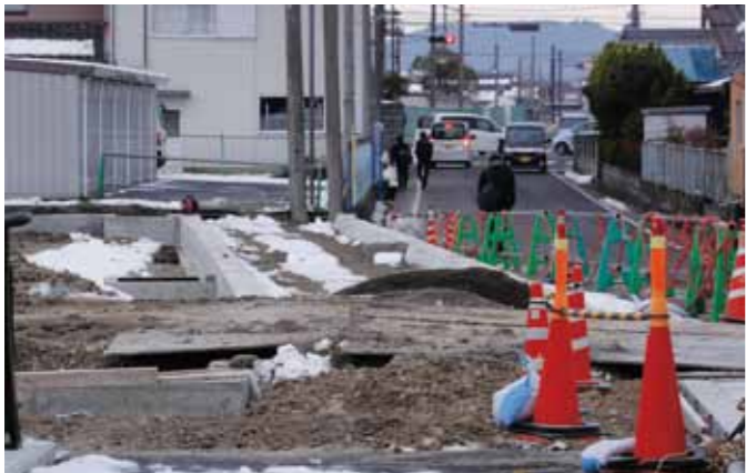
歩道工事が進められている躰光寺町地先
