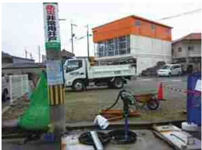
防災非常用井戸
