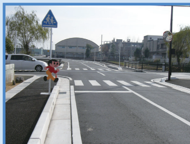
整備後(H23年完成)
