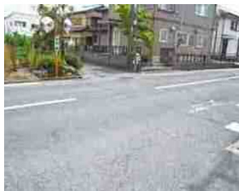
摩耗が激しく確認しづらい横断歩道
