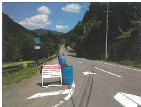
国道421号を中心に路肩に並べられたクッションドラム
