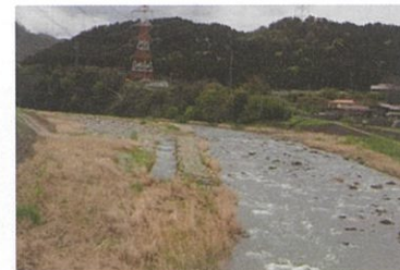
紅葉橋上流に設けられた暫定水路。試験データを正確にとるために、ちょうど100mの水路が設けられました。
