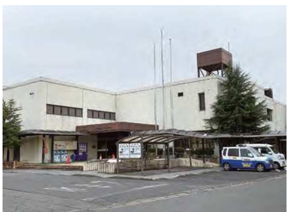
老朽化が進む湖東コミュニティセンター
