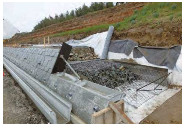
強化工事が進む愛知川堤防
