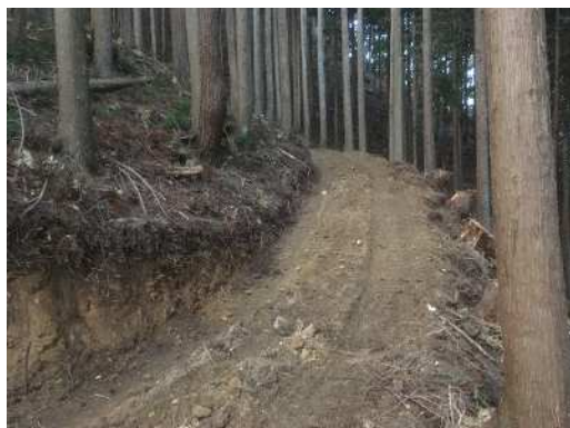
【現場作業② 作業道作設】
