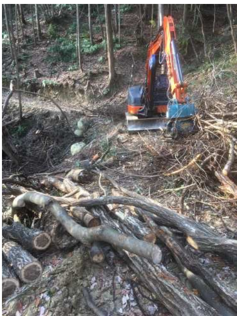
【現場作業① 間伐】
