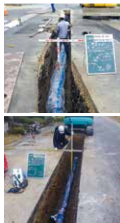
令和5年度の更新工事の様子
