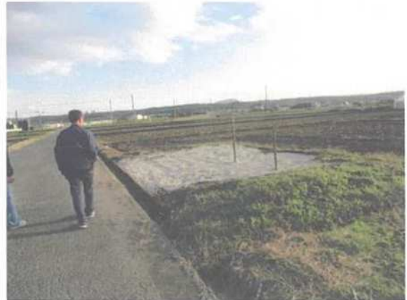
No.8 倒壊の恐れがあるため解体したポンプ小屋跡
