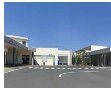
がん診療棟が新設された蒲生医療センター
