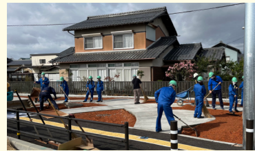
▲砕石敷均し作業をする生徒ら
