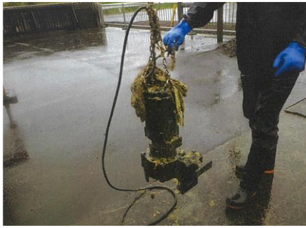
農村下水道処理施設のポンプに絡まっていた布類（2023年6月）
