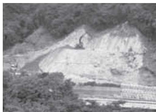
三重県いなべ市から掘り始められたトンネル工事
