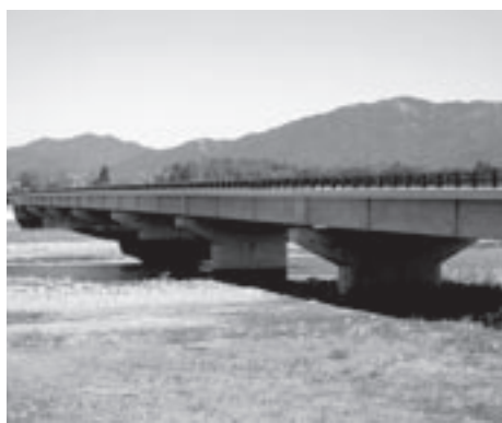
▲建設中の県道湖東八日市線 (愛東町鯉江地先～八日市市中小路地先)
