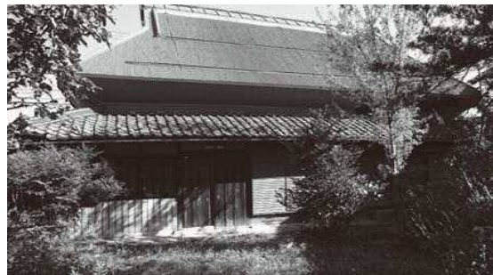
主を待つ空き家
