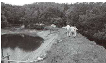
溜め池の点検をする関係者
