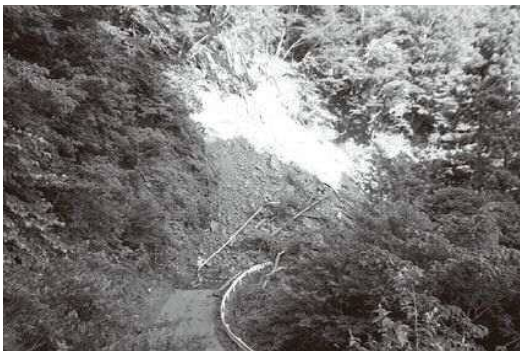
昨年発生した永源寺地区の土砂災害
