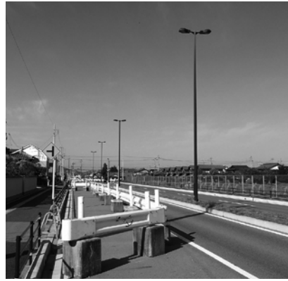
完成が待たれる外環状線
