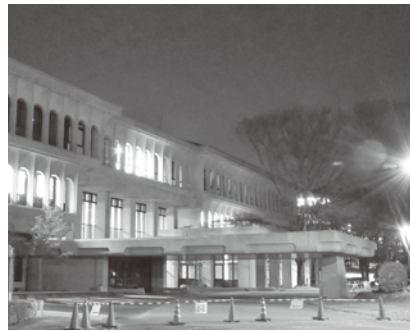
庁舎の照明が明るく、遅くまで残業は無いものと認識しています。
