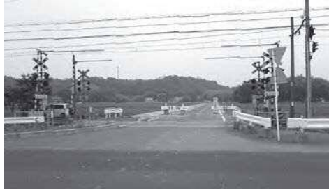
延伸工事が滞っている市道桜川石塔線
