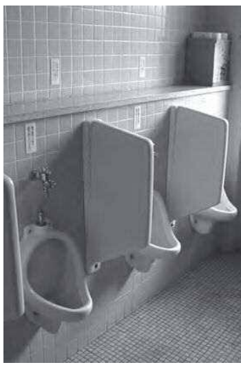
改修が待たれる能登川支所のトイレ
