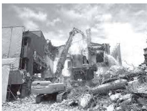
厳格な管理の下で行われる解体工事
