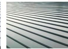
金属板葺（庇に用いる）瓦棒葺・一文字葺・段葺
