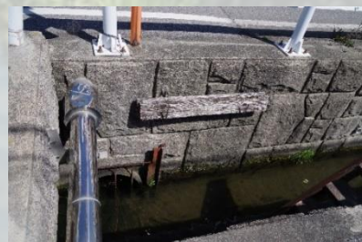
コンクリート擁壁
