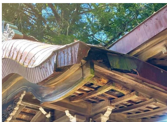
写真 2 望湖神社幣殿修理前
