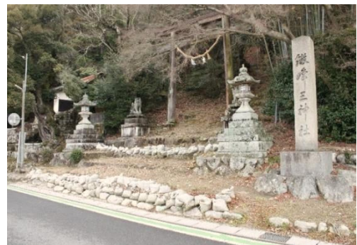
写真6 流出土砂の土留め
