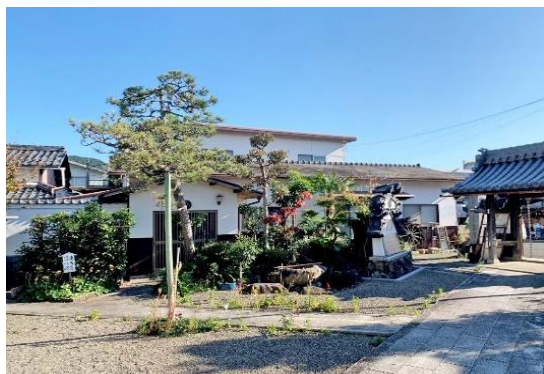
写真 1 正厳寺門信徒会館修理前
