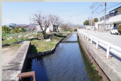
矢板擁壁（鋼製）
