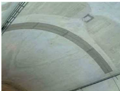
トンネル壁面の剥離防止工（はつり落とし+断面修復）15㎡当たりの比較
