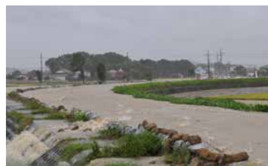
▲河川が越水し、道路の冠水や床上浸水のほか、農作物にも多くの被害が発生（平成25年の台風18号）。また、令和2年8月20日には、県内史上最高気温となる39.2℃を記録
