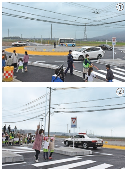
①ラウンドアバウトに流入する車両は、同一方向（時計回り）に進むため、右折車との衝突事故を防ぐことができます。 ②信号機がないので、しっかり左右を確認して横断しましょう。
