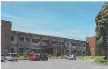
新校舎完成後、解体される校舎
