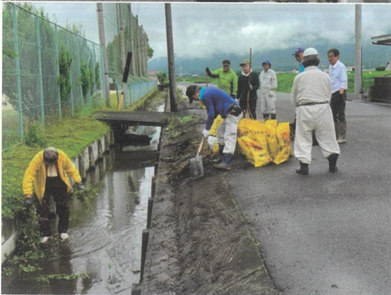
除草、剪定、排水路の土砂上げも実施
