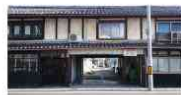
自治会館へ抜ける道、長屋の中央1階部分を除去して通路になったそうです。
