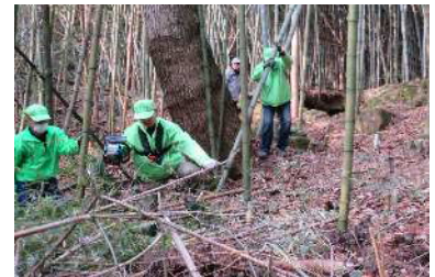
瓦屋禅寺参道整備
