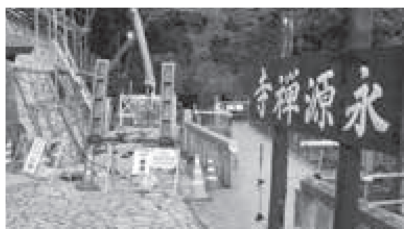
工事のため仮設道が設置された本山永源寺参道
