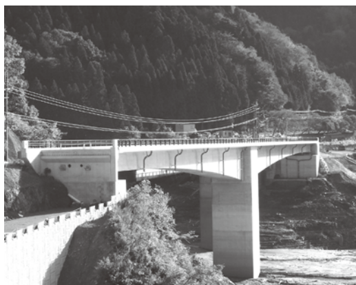
工事中の佐目橋
