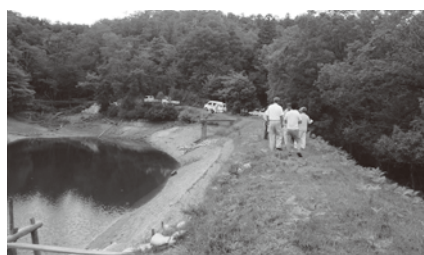
溜め池の点検をする関係者
