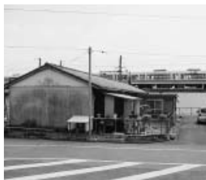
老朽化進む市営住宅
