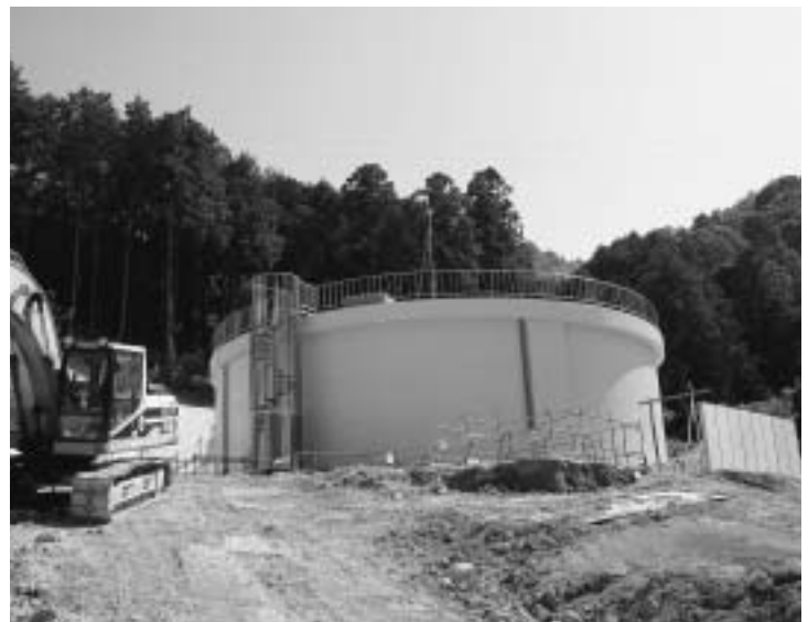
建設が進む能登川配水タンク
