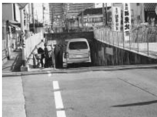
これで幹線道路？（垣見隧道）
