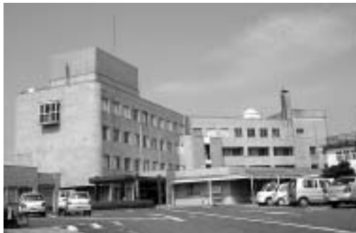
老朽化が進む蒲生病院
