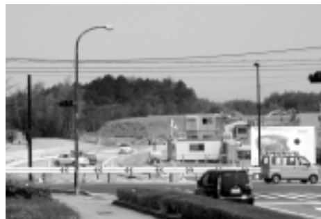
工事の進む布引運動公園（芝原工区）
