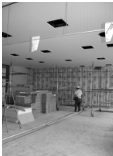
秋の開館をめざし急ピッチで工事が進む蒲生図書館
