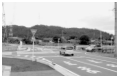
改良された紅葉橋北詰め交差点
