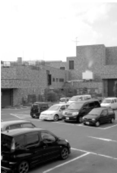
改修される文芸会館
