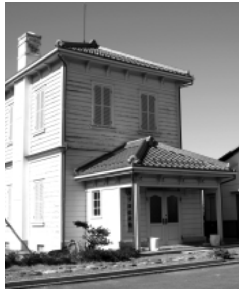
老朽化が進み早期改修が待たれるガリ版伝承館
