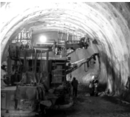
貫通した石樽トンネル
