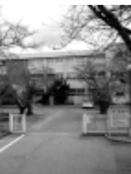
建て替えが予定されている中学校校舎
