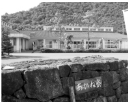
改修が必要とされるあかね寮
