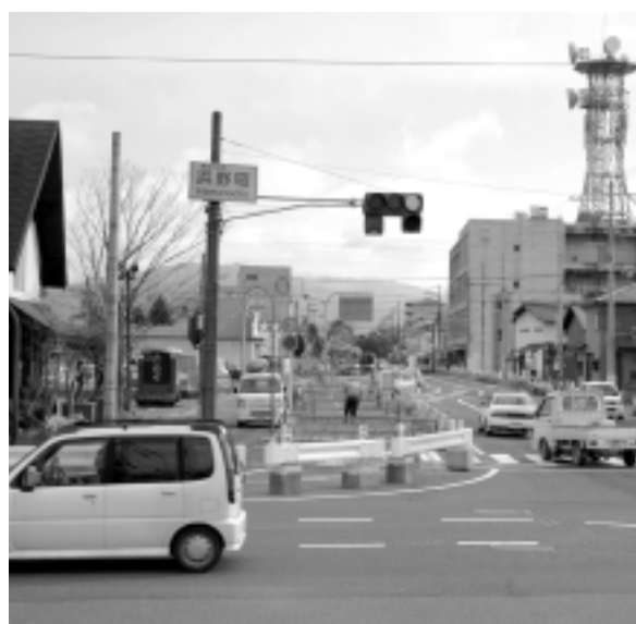
道路改良工事がすすむ八日市駅前通り
