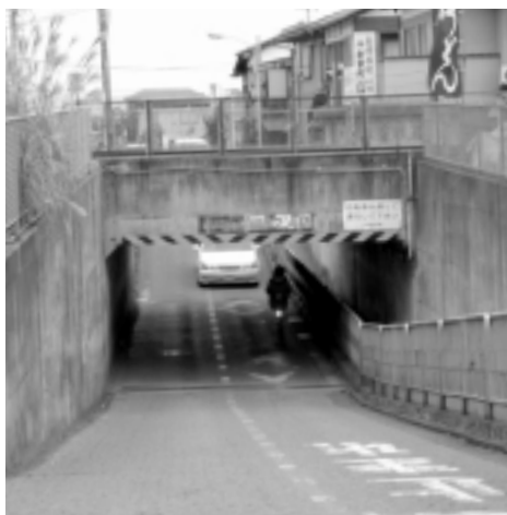
対向が危険な垣見隧道
