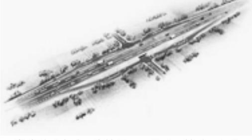
高速道路本線へ直接アクセス路を接続させる本線直結型のIC
