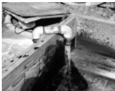
永源寺高野地先に掘削された温泉源
