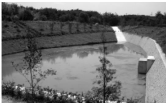
布引運動公園の調整池
