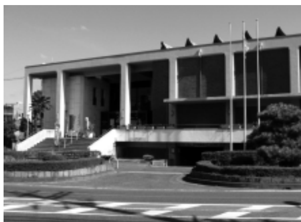
建て替えにより八日市地区公民館に生まれかわる予定の現・中央公民館
