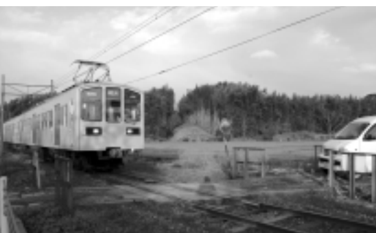
遮断機のない踏切 (布施町地先)
