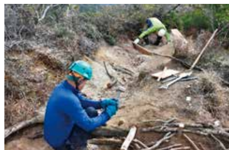
雨水によるガリー浸食に対する植生回復作業 (竜ヶ岳)
