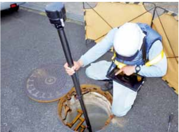
下水道管点検の様子
